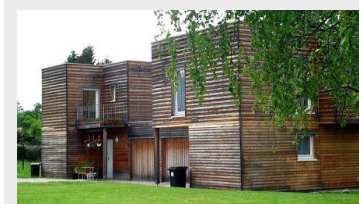
Pavillons jumelés à Thierville-sur-Meurthe 15 logements sociaux T3 T4. OPH Lunéville 2011 (25 lgts / ha)
