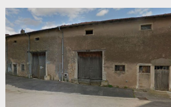
Démolition / reconstruction à Rosières-en-Haye – logements communaux adaptés 2018
