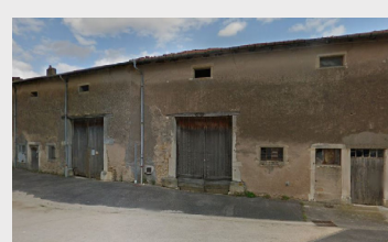
Démolition / reconstruction à Rosières-en-Haye – logements communaux adaptés 2018
