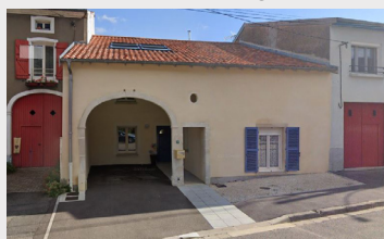
Maison à Bulligny
